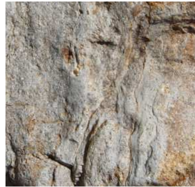
Blocs de la Tour Bourdon
