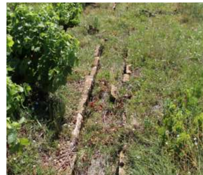
Des vestiges d'aménagements de gestion de l'eau attestent de la problématique de son infiltration
