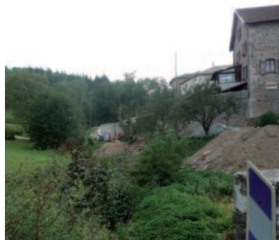
LA MAUVAISE Remblais communes d'Emeringes
